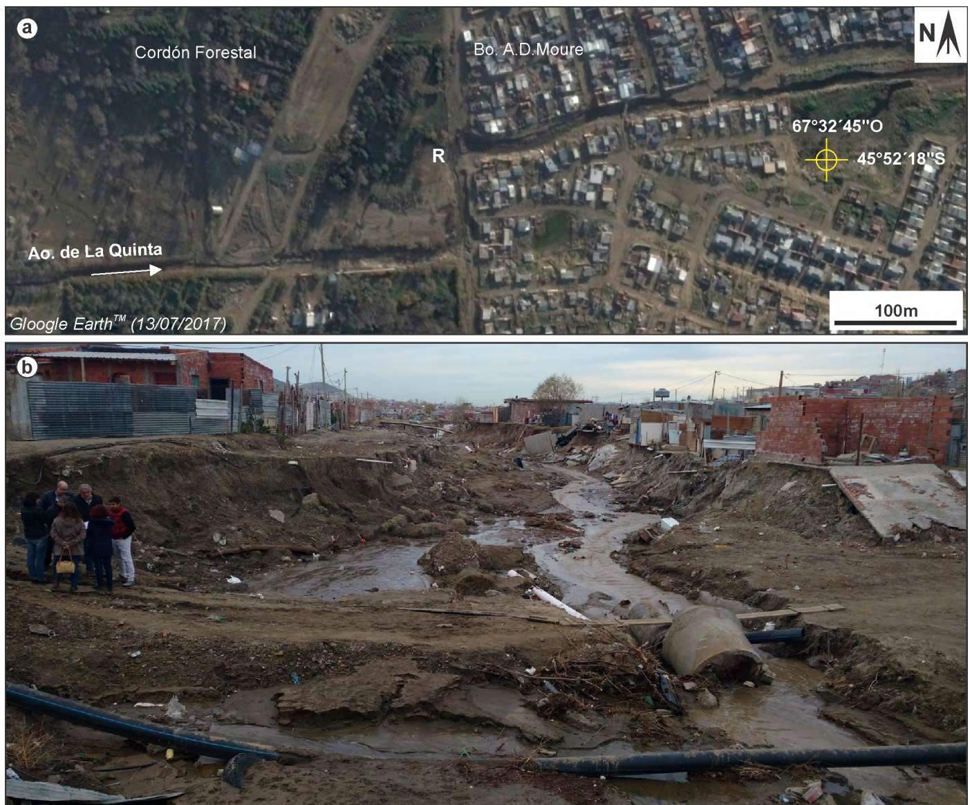
Figura 12. Asentamientos espontáneos sobre el arroyo De La Quinta dentro del éjido urbano: a) Imagen de Google Earth TM posterior al temporal, mostrando el impacto de la profundización del arroyo sobre las viviendas y población ubicada en los márgenes del cauce; b) Vista hacia el este del arroyo De La Quinta desde el punto R. Fotografía obtenida el 4 de julio de 2017
