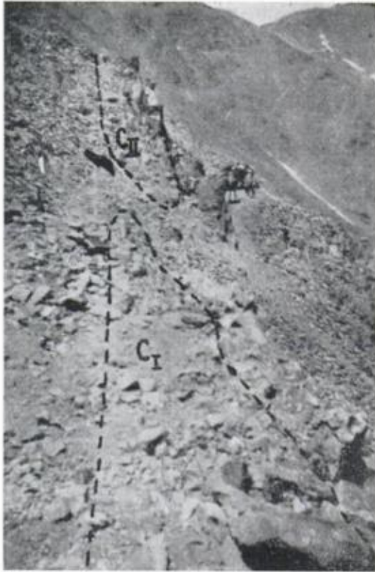
Fig. 4. — Tomada con rumbo N-60°-E. Vista de los afloramientos de hematita de las concentraciones 1 y 2 de la veta I. Se notan los afloramientos aislados, cubiertos por detritus de falda y mineral de veta de las cuales, sólo quedan crestas aisladas luego de la explotación de 800 toneladas extraídas con el fin de realizar ensayos metalúrgicos comerciales. Se puede apreciar la senda en donde están detenidos los mulares.
