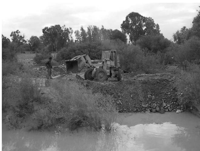
Figura 5: Tareas de reparación por rotura en uno de los laterales de la presa construida como defensa de la calle 15.
