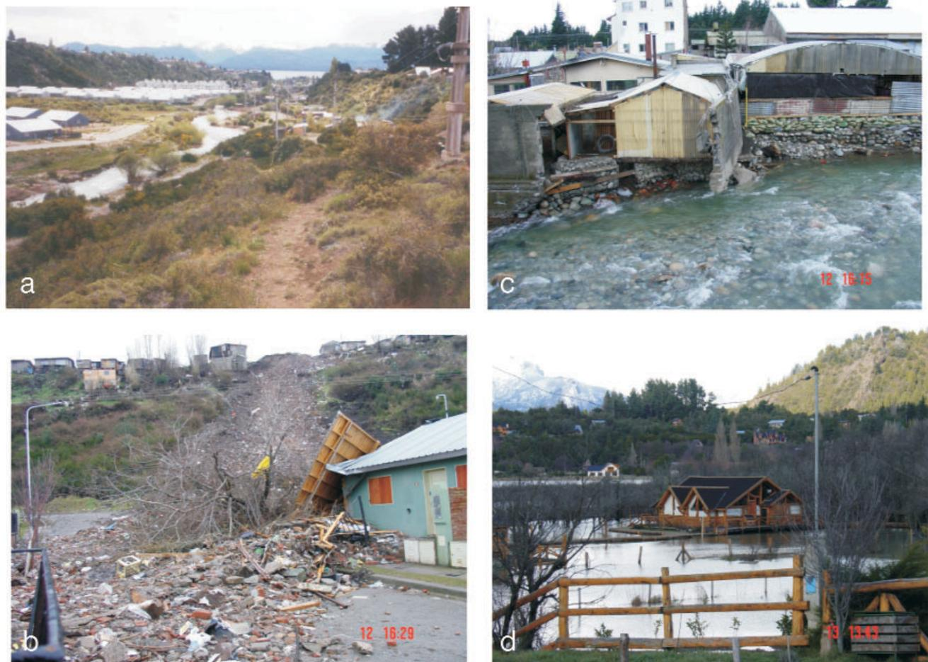
**Figura 4:** a) localización de los barrios del IPV en la planicie aluvial y terraza baja del arroyo Ñireco; b) efectos erosivos del arroyo Ñireco sobre construcciones incorrectamente ubicadas en una barra del mismo; c) deslizamiento de la Barda del Ñireco, ocurrido como respuesta a grandes precipitaciones acaecidas en junio del 2004; d) anegamiento por ascenso freático en el denominado Mallín del 12, sobre la Avda. Bustillo, en Playa Serena.
