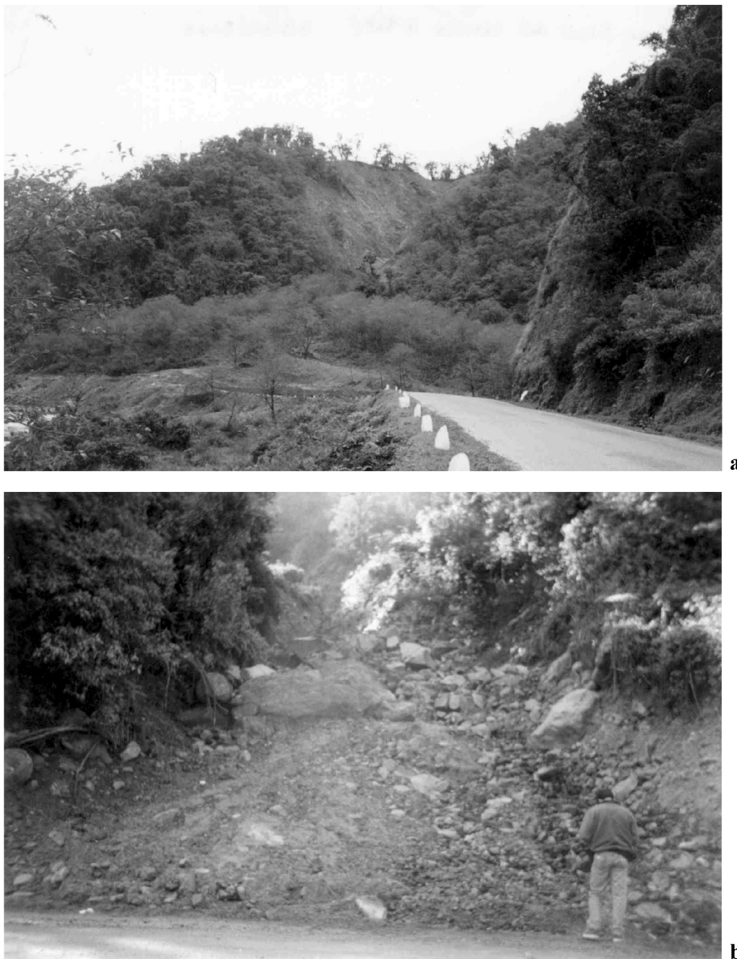
Figura 6: a , Flujo de detritos en el km 39 en los esquistos listados, se puede observar la cicatriz de deslizamiento original y sobre la ruta el cono de detritos que depositó. b , Depósito de un flujo hiperconcentrado.
