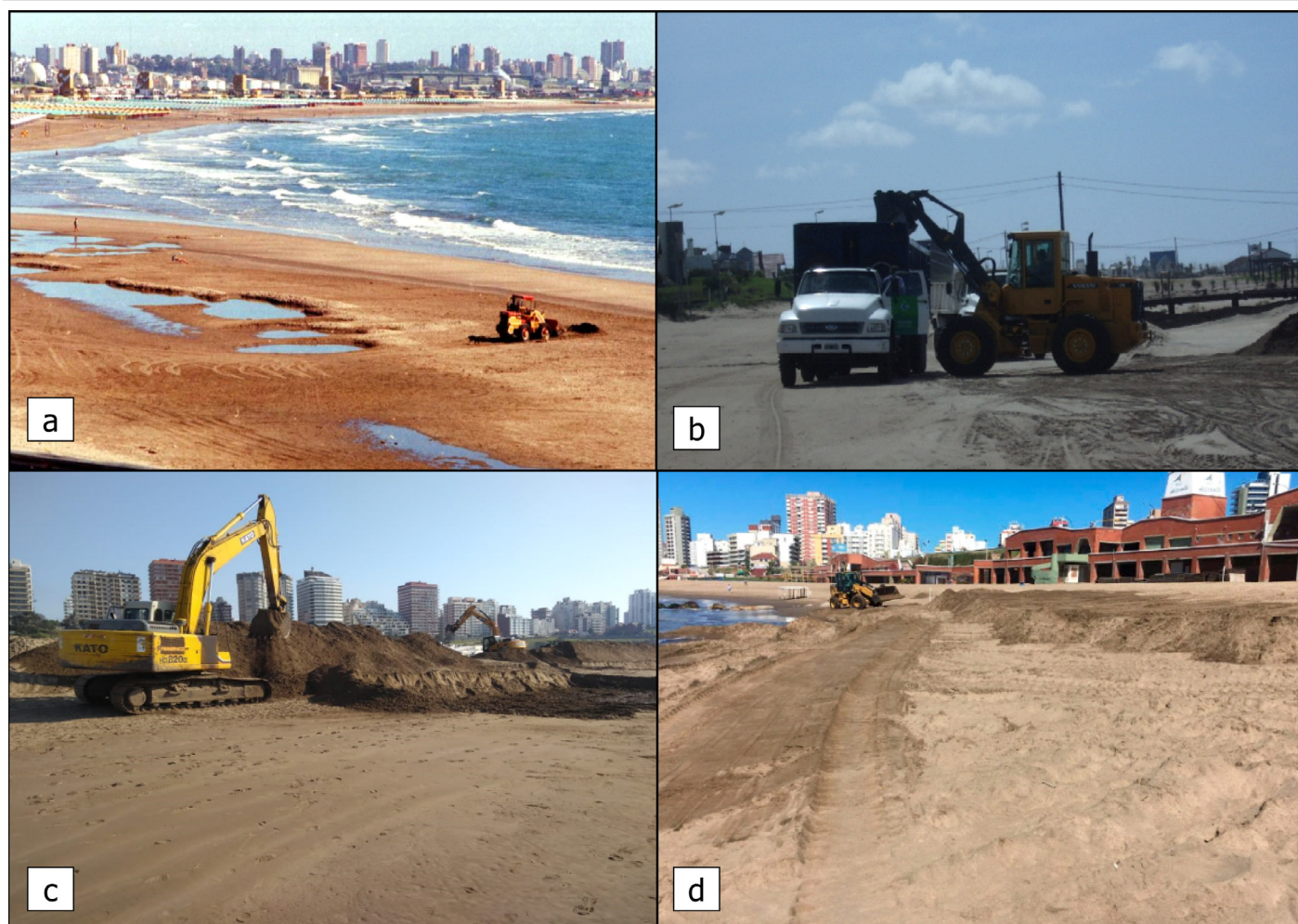
Figura 8. a) Movimiento de arena en Punta Mogotes previo a la temporada estival (1990); b) Limpieza de avenida costanera en Pinamar; c) Movimiento de arena en Playa Grande (agosto de 2018, General Pueyrredon); d) Movimiento de arena en balneario de playa La Perla (setiembre 2018, General Pueyrredon).
