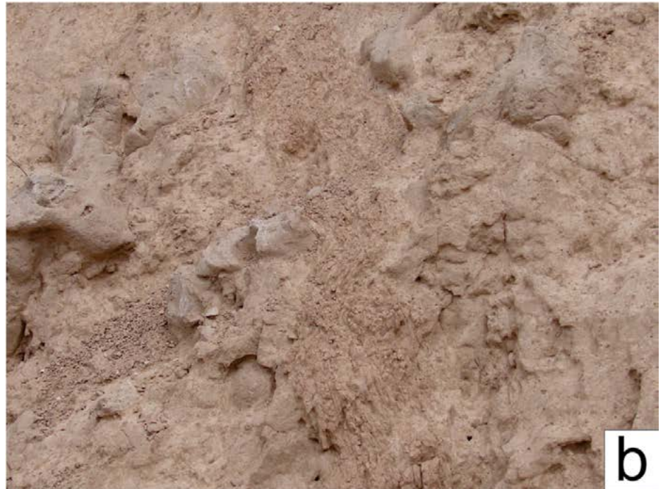
Figura 13. a) Pared con estrias de falla en el cerro Patagua (ubicación en Fig. 1); b) Fallas secundarias cercanas a la falla Valle Daza (ubicación en Fig. 1).
