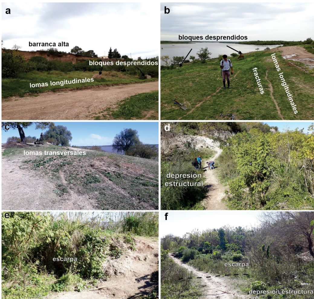
Figura 9. Morfologías superficiales en el sector afectado por proceso de remoción en masa. (a) Barranca y planicie baja; se observan bloques desprendidos de la barranca alta; (b) loma longitudinal afectada por fracturas paralelas al eje; (c) loma transversal, generada por la erosión de las lomas longitudinales a partir de cañadas y surcos transversales a la planicie baja; (d) depresión estructural adyacente a la barranca, en el pie del talud; e y f) escarpa en la margen externa de la depresión de aproximadamente 1 m de altura.
