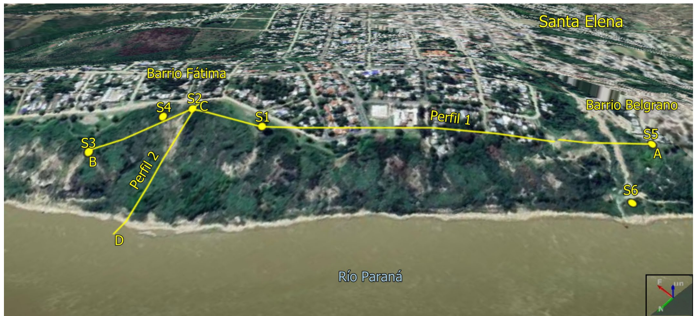
Figura 7. Imagen de la zona afectada por remoción en masa en la ciudad de Santa Elena con la ubicación de las perforaciones geotécnicas y los perfiles interpretados.
