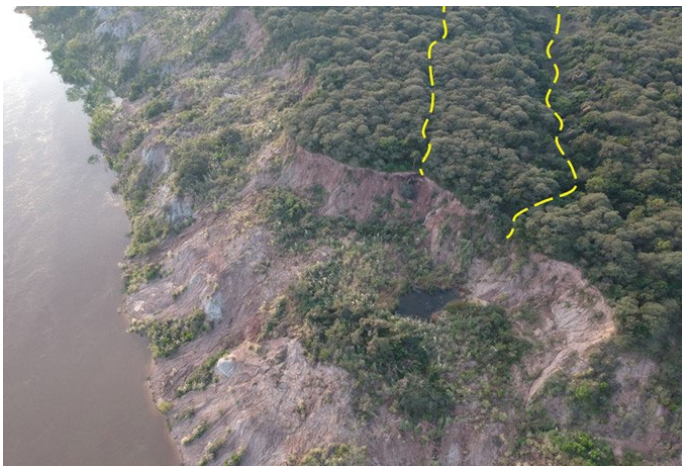
Figura 29. Depósitos asociados a movimientos complejos, producto de una secuencia de deslizamiento rotacional y posteriores flujos de tierra, a partir del material fino deslizado. La presencia de una laguna subcircular, posiblemente formada por disolución, o bien por colapso o tubificación, pudo haber favorecido la inestabilidad. En líneas de puntos se indican dos cauces que alimentaban la laguna previamente al deslizamiento.
