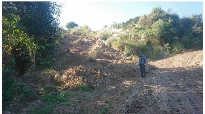
Figura 26. Vista del frente de avance de un depósito de flujo de tierra, compuesto por arcillas saturadas.
