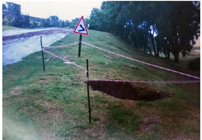
Figura 16. Pozo circular de aparición repentina, cuya profundidad alcanza el nivel freático, documentado por Mesquida (2014).
