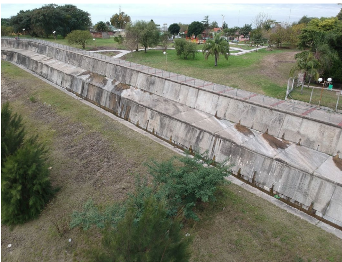
Figura 2. Obra de estabilización de la barranca, en la zona de la calle Nogoyá.
