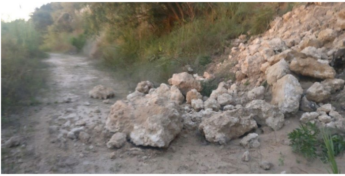
Figura 37. Caída de bloques de calizas de la Formación General Alvear (Unidad Geotécnica III), por descalce producto de la erosión de las arenas infrayacentes de la Formación Itzaingó (Unidad Geotécnica IV).
