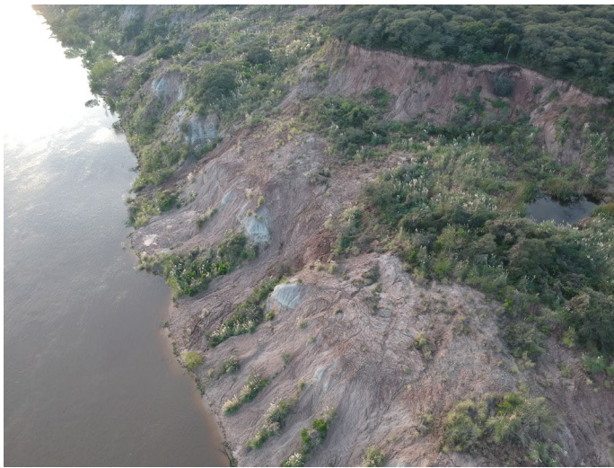
Figura 24. Deslizamientos rotacionales profundos, con base en las calizas de la Unidad Geotécnica III, y posteriores flujos de tierra a partir del material deslizado. Se observa una laguna bajo la escarpa principal (derecha de la foto), que indica un estado de saturación del terreno.
