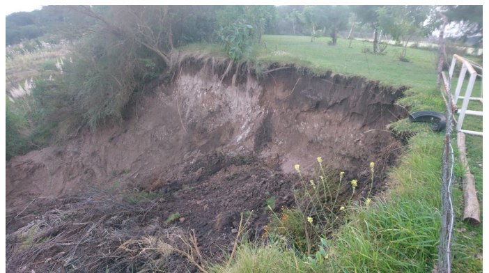
Figura 22. Deslizamiento rotacional desarrollado en el sector superior de la barranca, desarrollado dentro de la Unidad Geotécnica I.
