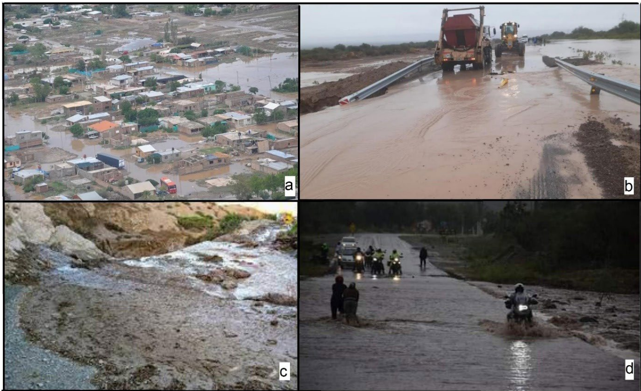
Figura 1. Imágenes tomadas de diarios locales: a) Media Agua, Sarmiento ( https://www.tiempodesanjuan.com/departamentales/2013/2/2/media-agua-recupero-agua-potable-horas-despues-crecida-26144.html ); b) Matagusanos, Ruta Nacional N 40. ( https://www.diariodecuyo.com.ar/sanjuan/Temporal-en-San-Juan- algunas-rutas-estan-cortadas-y-hay-badenes-cubiertos-por-el-agua-20220127-0019.html ); c) Parque El Leoncito, Calingasta ( https://www.diariodecuyo.com.ar/sanjuan/Un-aluvion-destrozo-el-ingreso-del-Parque-El-Leoncito-y-hay-19-turistas-varados-en-su-interior-20220113-0014.html ); d) Ruta Provincial N 60, Ullum ( https://www.canal13sanjuan.com/san-juan/2021/3/1/advierten-por-nuevas-tormentas-mas-intensas-en-san-juan-155168.html )
