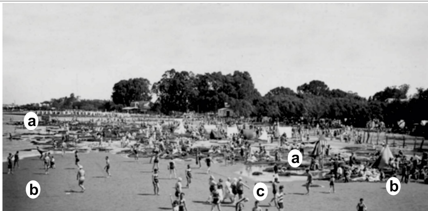
Figura 3. Los bañistas de la playa pública de Olivos. Buenos Aires, 1936. Fotografía publicada en #CarasyCaretas N°1946. Archivo General de La Nación. AR-AGN-CyC01-f-278-408951. Se distingue la playa disipativa original con la topografía típica de barras longitudinales y canales. a. Plataforma de abrasión. b. Crestas de las barras. c. Canal.
