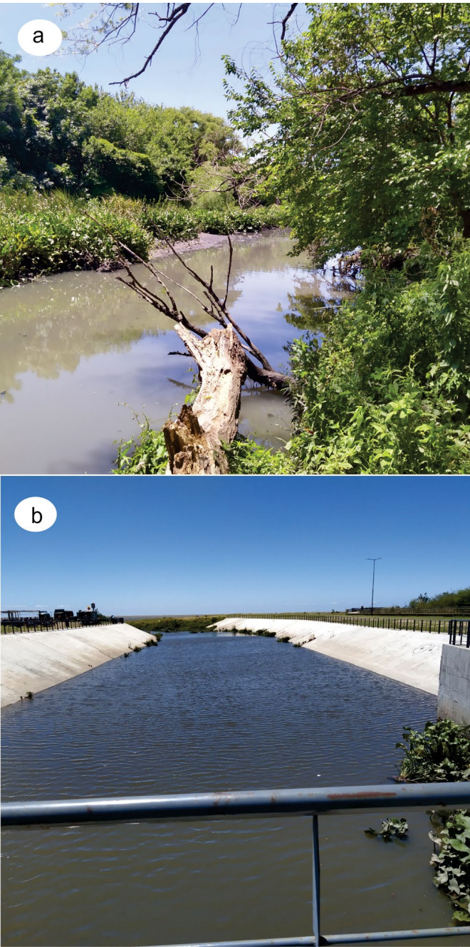
Figura 6. Comparación entre un curso artificial con una evolución natural (a) y otro intervenido con defensas (b). Obsérvese la generación del bosque en galería asociado a la evolución natural.
