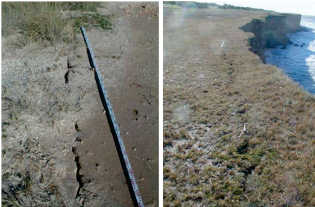
Figura 7. La meteorización física domina en los sectores donde la lluvia se infiltra en grietas en los acantilados al sur de Chapadmalal (la escala es una mira estadimétrica extendida en 4 m).
