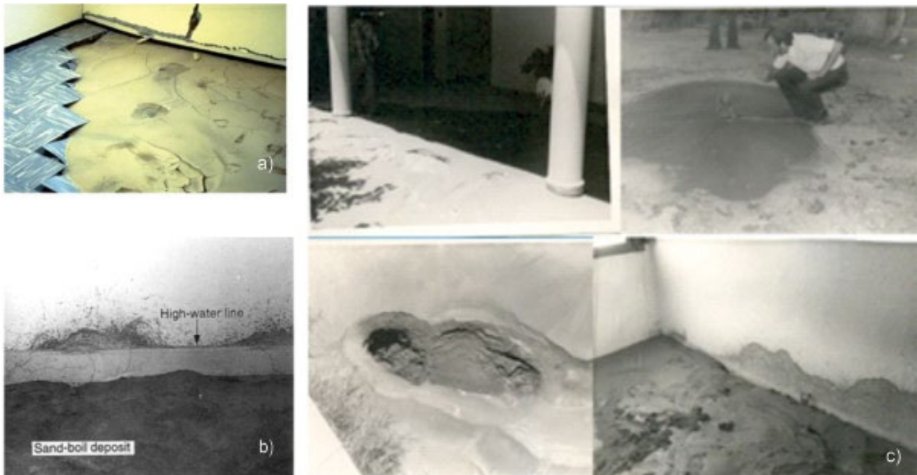
Figura 5. a y b) Cráteres y volcanes de arena en el interior de algunas viviendas de un barrio en Caucete. Las manchas en la pared muestran la altura que alcanzó el agua. Fuente: Youd y Keefer (1994). c) Licuación de suelos en distintos edificios y viviendas del departamento Caucete. Fuente: INPRES (1993).
