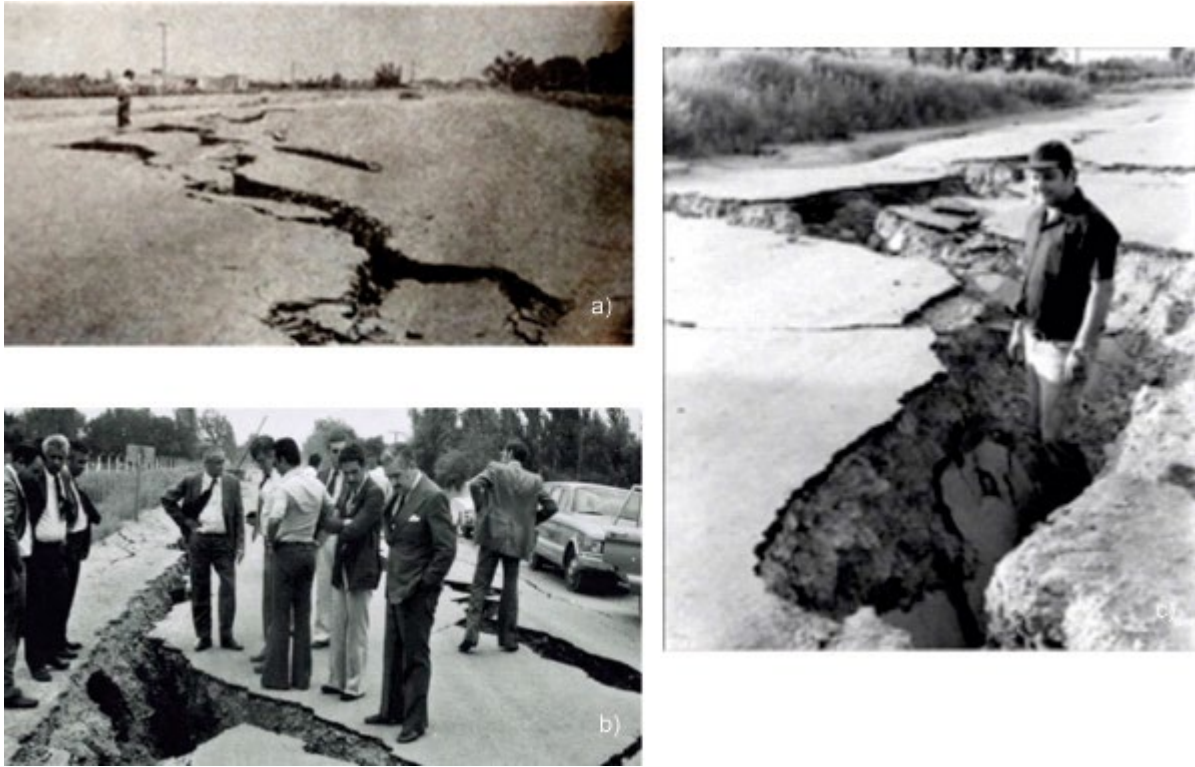
Figura 6. a) Grietas longitudinales en el extremo sur de la pista de aterrizaje del Aeropuerto La Chacritas. b y c) Grietas transversales en calles de Caucete, con un ancho y profundidad considerable (aproximadamente 1-1.50 m). Fuente: Instituto Sismológico Zonda. https://www.cadena3.com/noticia/sociedad/se-cumplen-40-anos-del-sismo-de-caucete-de-1977_196683 .
