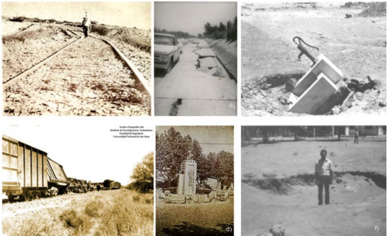
Figura 7. a y b) Vías del ferrocarril afectadas por el sismo y descarrilamiento de vagones producido por el evento (Fuentes: INPRES, 1977; Instituto de Investigaciones Antisísmicas). c-f) Daños en canales de regadío, pozos de agua, monumentos y áreas de cultivos por licuación de suelos, asentamientos diferenciales, entre otros (Fuentes: Instituto Geofísico Volponi, INPRES, 1977, 1993).
