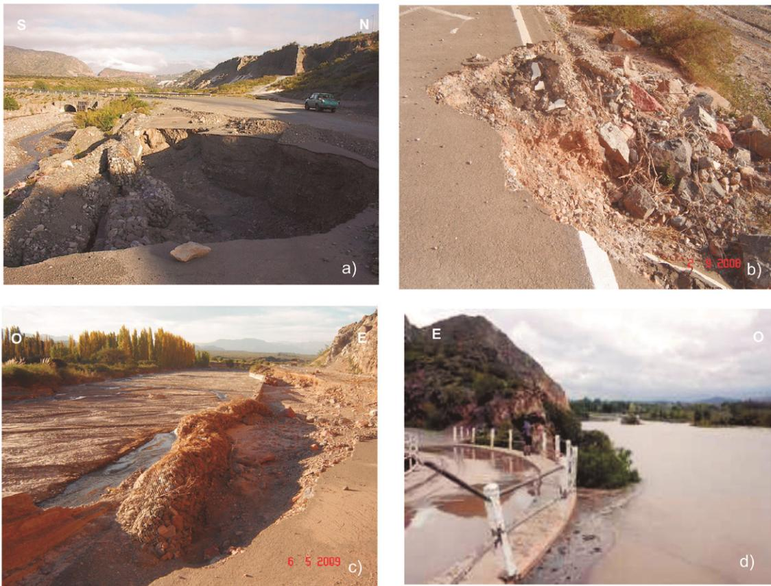
**Figura 2:** Daños producidos en el departamento Sarmiento: a) Corte en la ruta Nacional 149, recién inaugurada, en el acceso a Pedernal; b-c) Cortes en la ruta Nacional 149, en los veranos de 2008 y 2009; d) Durante las lluvias de verano de 2011, el agua superó la cota del embalse ubicado en Pedernal (Fotografía Diario de Cuyo).
