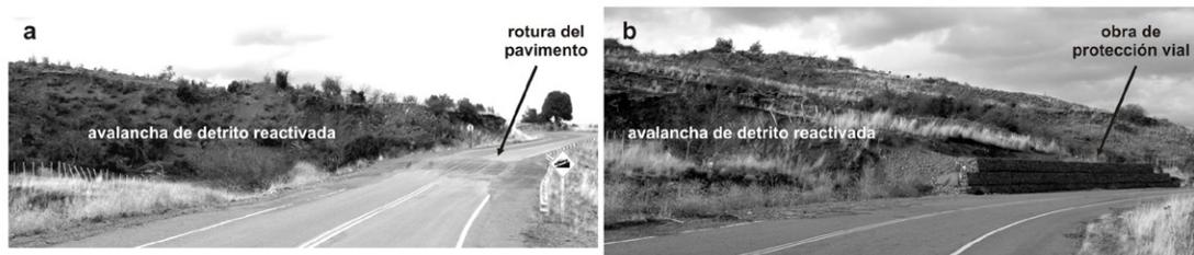
**Figura 10:** Corte de la ruta provincial N° 72 sobre el sector distal de las unidades RP4 y RP5 (Fig. 7). a) Tramo de dicha carretera cuyo pavimento es deformado y fracturado desde el inicio de las obras (año 2005) y evidencia la continuidad del movimiento aguas abajo de la carretera; b) Gaviones diseñados para contener los materiales y para facilitar el escurrimiento del agua.
