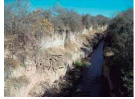
Figura 3: Vista del canal hacia aguas arriba, al Sur del tramo de estudio, donde se observa la marcada incisión del lecho conservando el ancho inicial.
