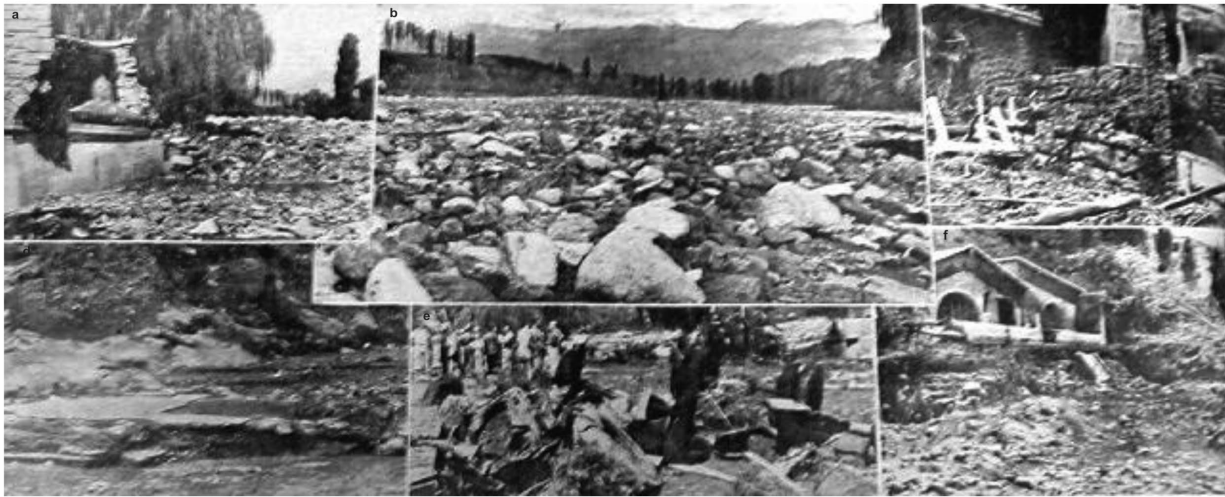
Figura 5: Daños ocasionados por el flujo de detritos/aluvión en Potrerillos en 1954 proveniente del arroyo El Salto. a-c-f) Daños en viviendas e infraestructuras. b-d-e) Material arrastrado por el flujo de detritos/aluvión. Fuente: Diario Los Andes.
