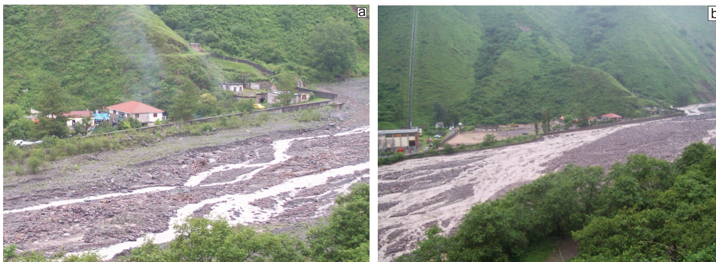
Figura 6: a) Se observa la terraza fluvial del río Reyes adosada a lo largo de toda la defensa, dos días antes del evento. b) Vista panorámica de la terraza luego del evento. A la izquierda de la fotografía se observa la terraza fluvial vegetada, mientras que a la derecha está erosionada. Se distingue además el cambio del curso del río recostado hacia el sur, contra la defensa. (Fotos del Ing. Pablo Agüero)
