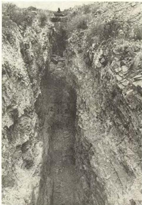
Fig. 7. — Mina « Cama Cortada ». Labor n° 14 vista desde el Norte. Obsérvese el ensanchamiento y estrangulación de las tres franjas de mineralización.
