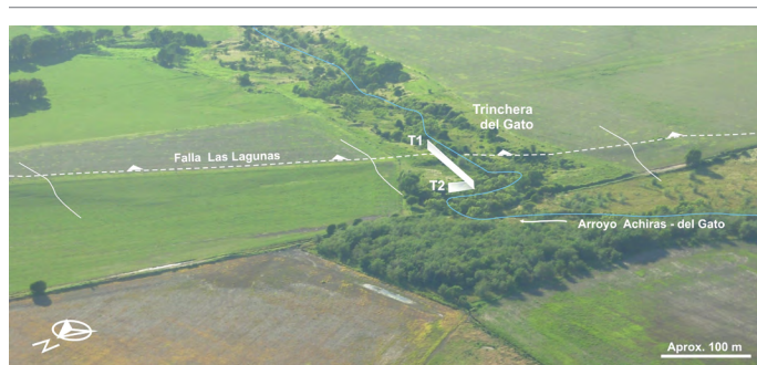
Figura 6. Foto aérea oblicua en donde se indican a la falla Las Lagunas con líneas de trazos, con línea continua la morfología superficial de la escarpa y con recuadros blancos en perspectiva la trinchera del Gato (T1 y T2).
