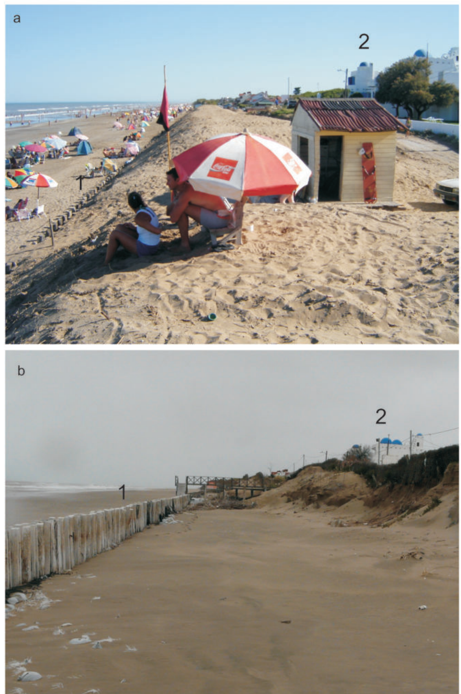
Figura 5: Comparación fotográfica de la recarga artificial en la zona de alta erosión de las Toninas en el año 2007. La figura A muestra la recarga en enero del 2008, pueden distinguirse aún las estacas en el frente (1) y la duna recargada y la casa tomada como referencia (2). La figura B muestra la pérdida de la recarga el 22 de Julio de 2009, y un retroceso del pie de dunas de unos 11 m.
