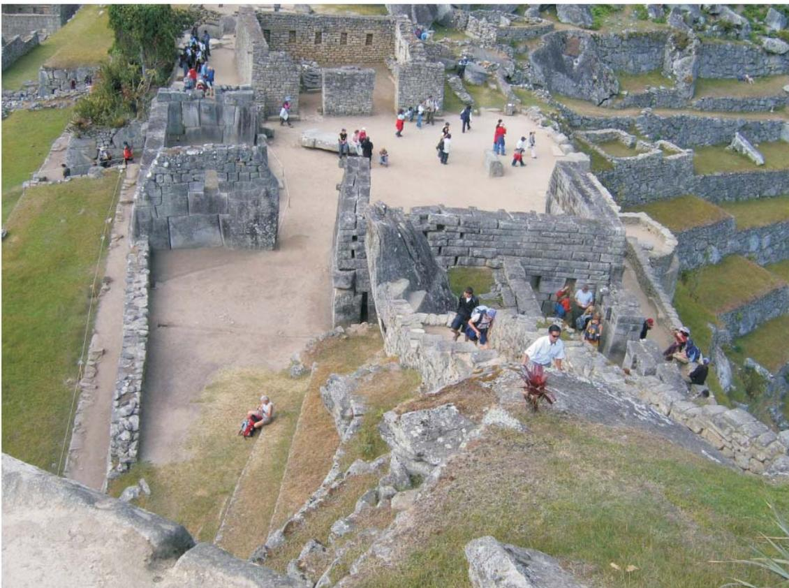
**Figura 12:** Templo de las Tres Ventanas con separación de juntas en las paredes norte y sur debido a asentamientos. Vista tomada mirando al sur.
