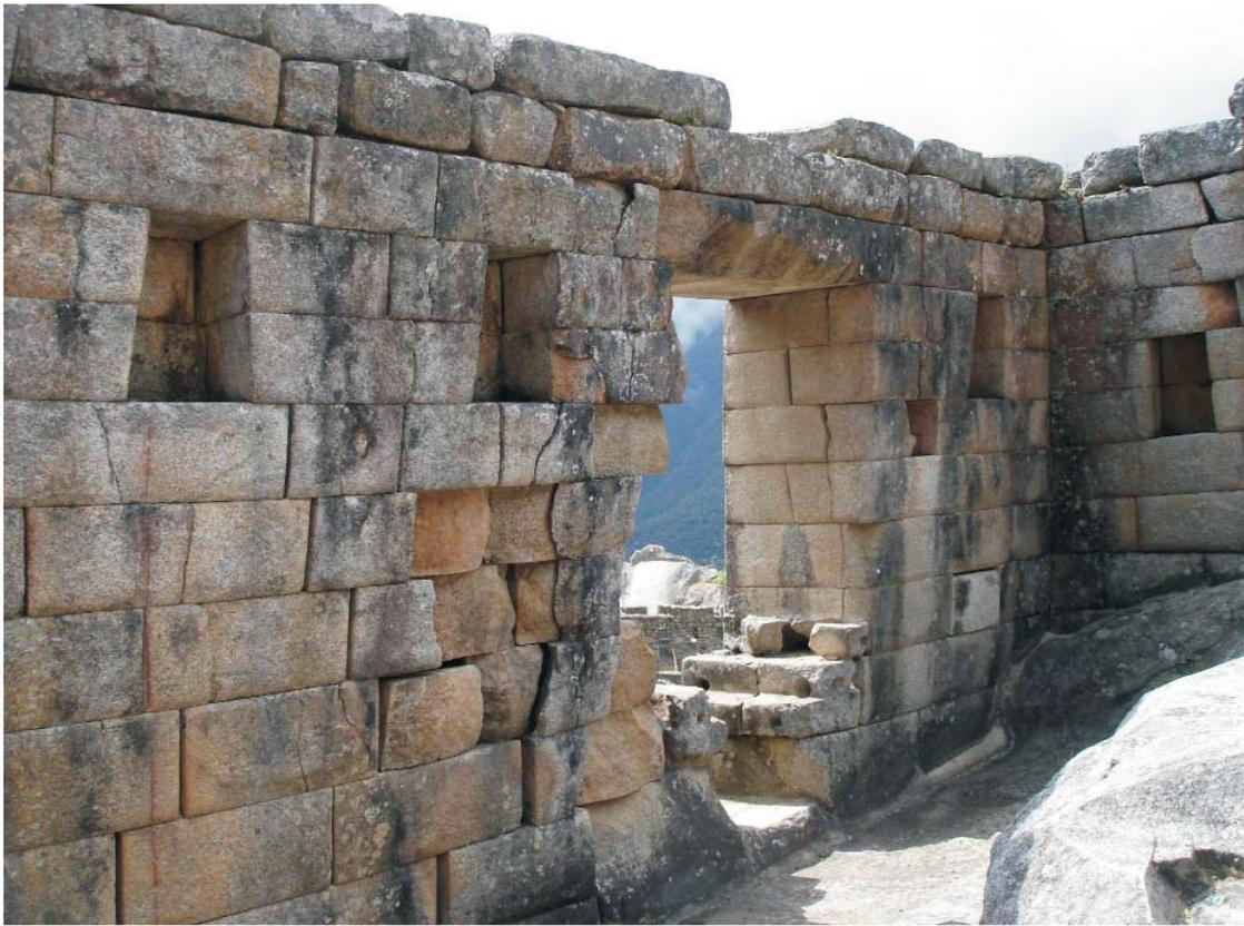
**Figura 16:** Interior de la Puerta de las Serpes con separación de juntas y efectos de meteorización, además de los posibles incendios.
