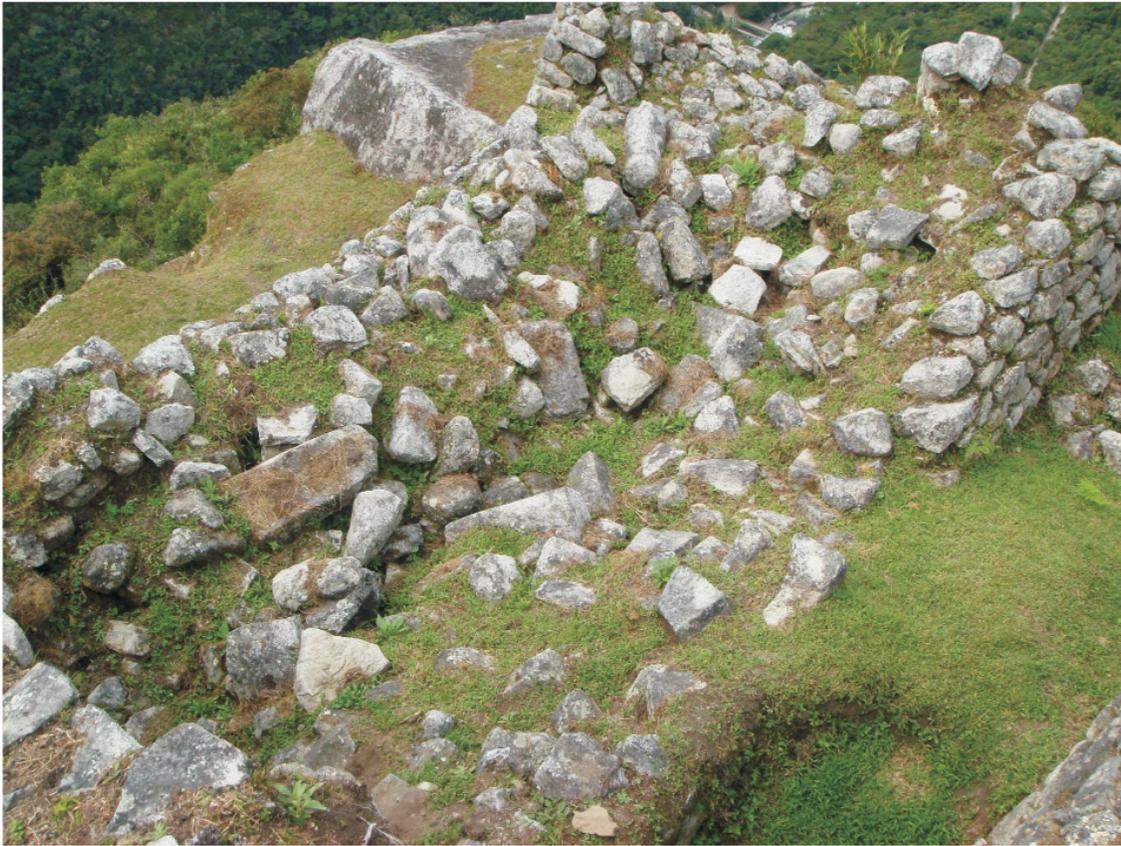
**Figura 18:** Proceso de sufusión que ha causado el colapso de muros en este recinto (Conjunto13).
