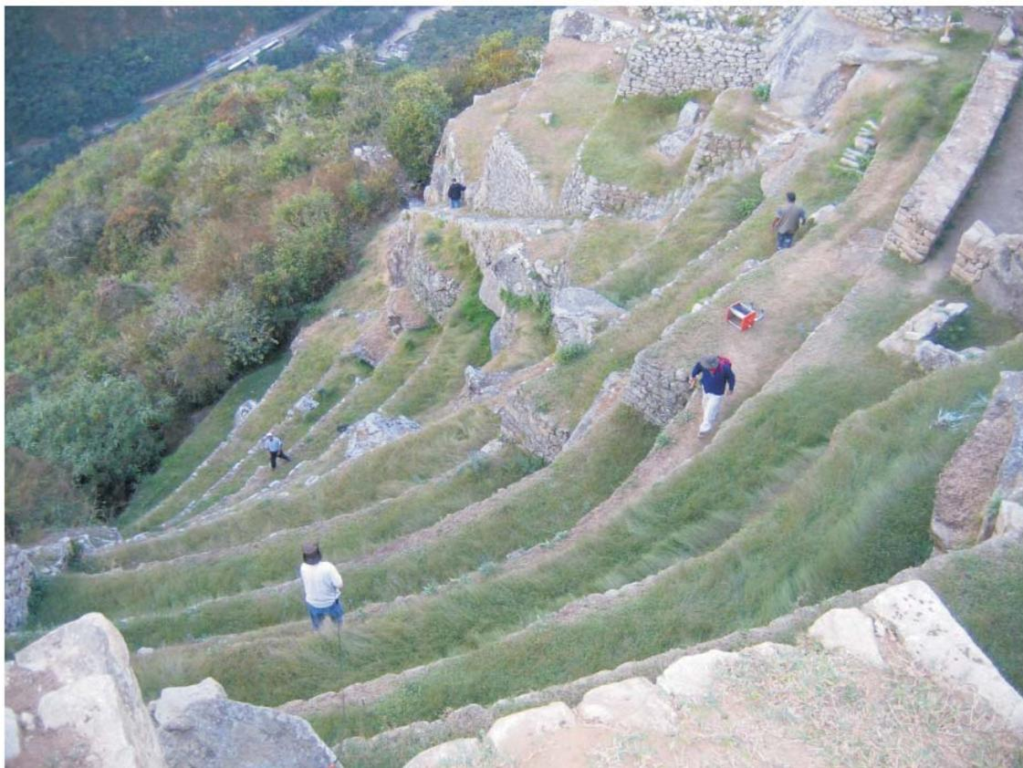
**Figura 19:** Deslizamiento estabilizado por los incas mediante las terrazas del Conjunto de Andenes 13.
