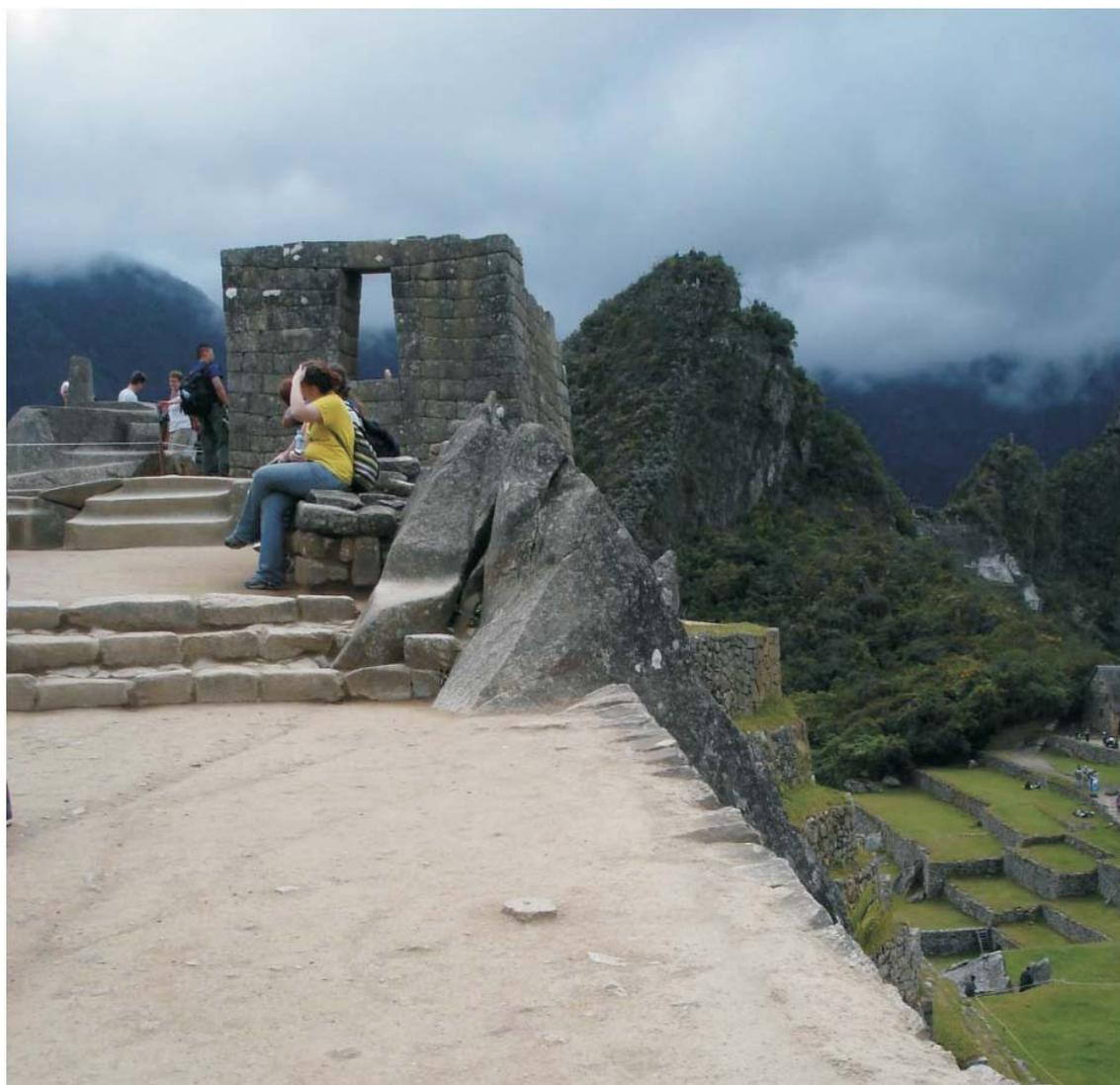
**Figura 17:** Fractura que corta el granito y permite la infiltración de aguas. En primer plano, rastros de erosión superficial del piso impermeable.
