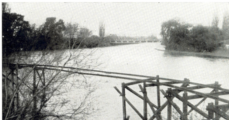
Fig. 3. — Vista del rio Colorado, desde el puente del F. C. S.
