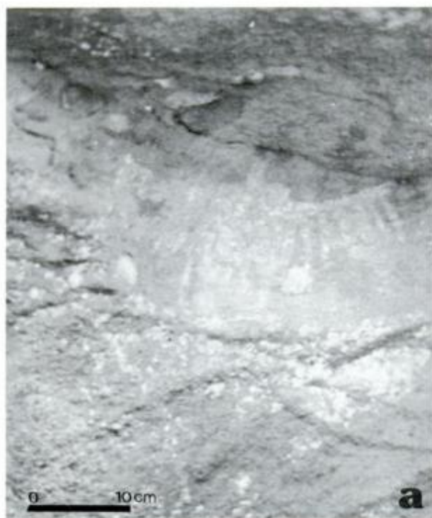
Figura 6: a, Eflorescencias salinas depositadas sobre "El Cóndor"; b, descamaciones sobre "El Colonizador".
