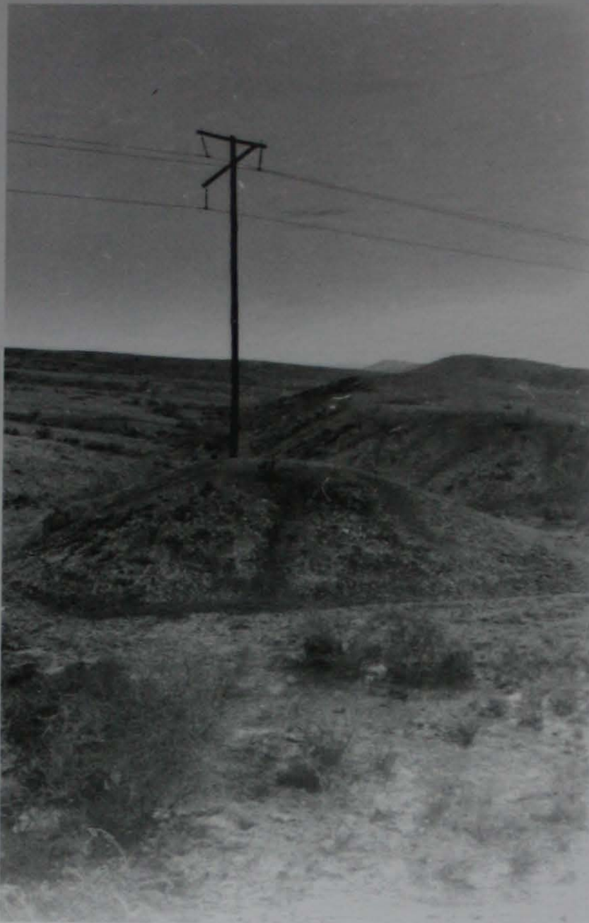
Figura 5: Línea de alta tensión que se dirige hacia el norte sobre el labio elevado de la falla La Laja.
