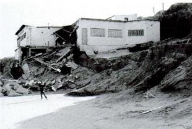
**Figura 5:** Una tormenta de noviembre de 1992 causó la erosión de la acumulación medanosa sobre la que se asentaban las construcciones sanitarias del Balneario San Patricio, Ensenada de Mogotes.
