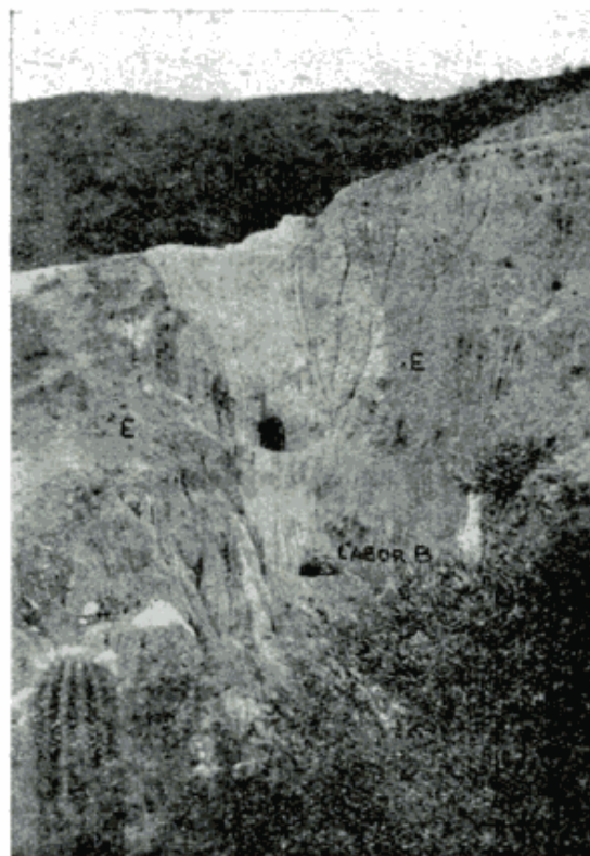
Fig. 7. — Mina « San Alfredo ». Mutquín. Vista hacia el sur, mostrando la trinchera abierta en una faja de la roca cuarzoso blanquecina, en ambiente de esquistos (E) más o menos alterados.
