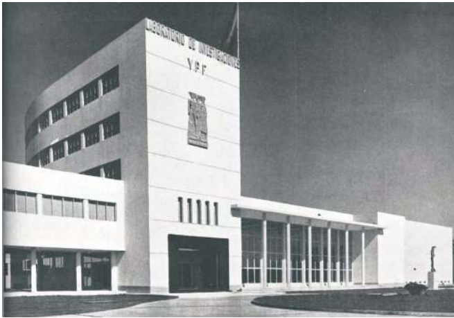
Figura 5: Edificio central del Laboratorio de Investigaciones de YPF en Florencio Varela (Revista Nuestra Arquitectura, noviembre de 1942).
