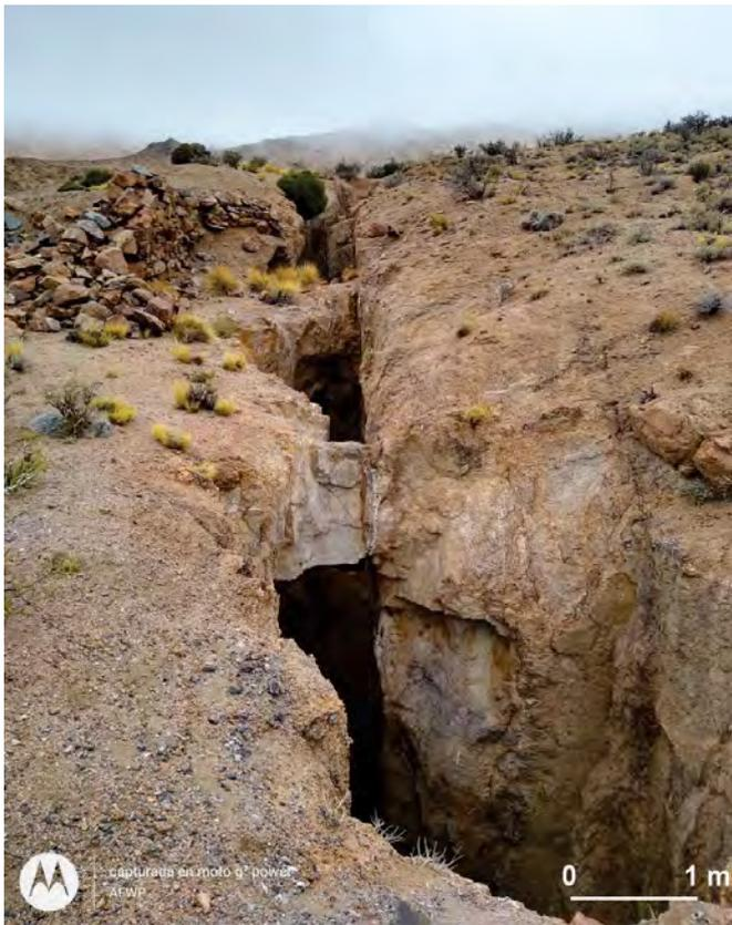
**Figura 3.** Vista al SO. Galería en mina La Cortada, sujeta por pilares de roca, de aprox. 12 m de profundidad.
